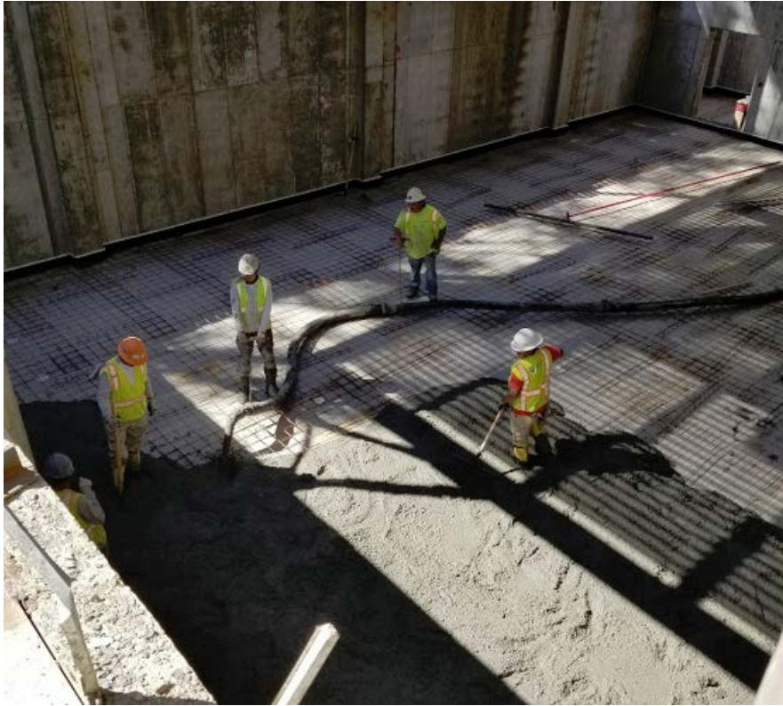
First floor concrete slab on grade pour
