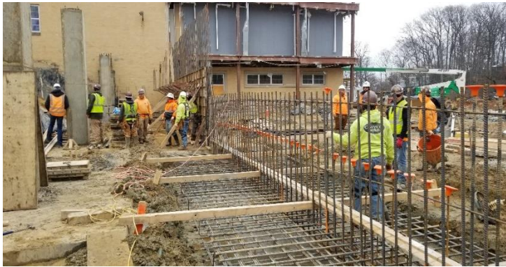
L1/L2 Foundation wall (before)
