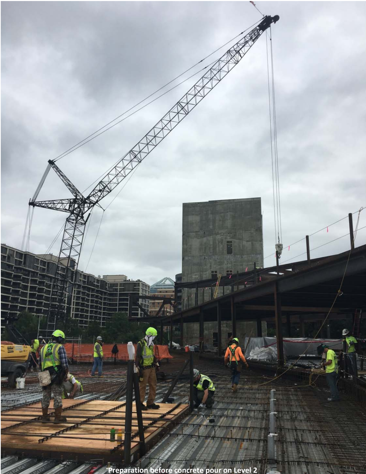
Preparation before concrete pour on Level 2
