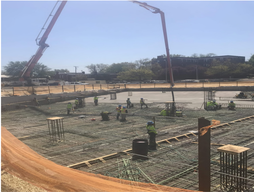
GARAGE UPPER LEVEL CONCRETE DECK POUR IN PROGRESS
