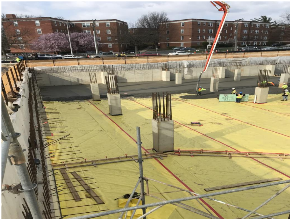
GARAGE LOWER LEVEL CONCRETE SLAB POUR IN PROGRESS
