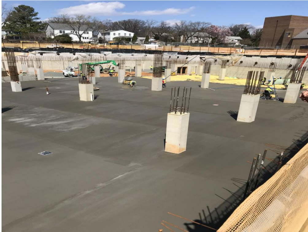
GARAGE LOWER LEVEL SLAB POUR COMPLETE
