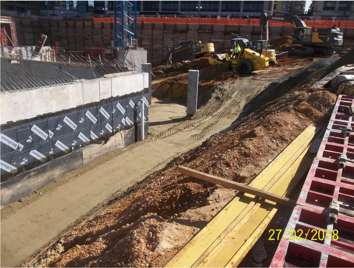
Backfill @B2 level
