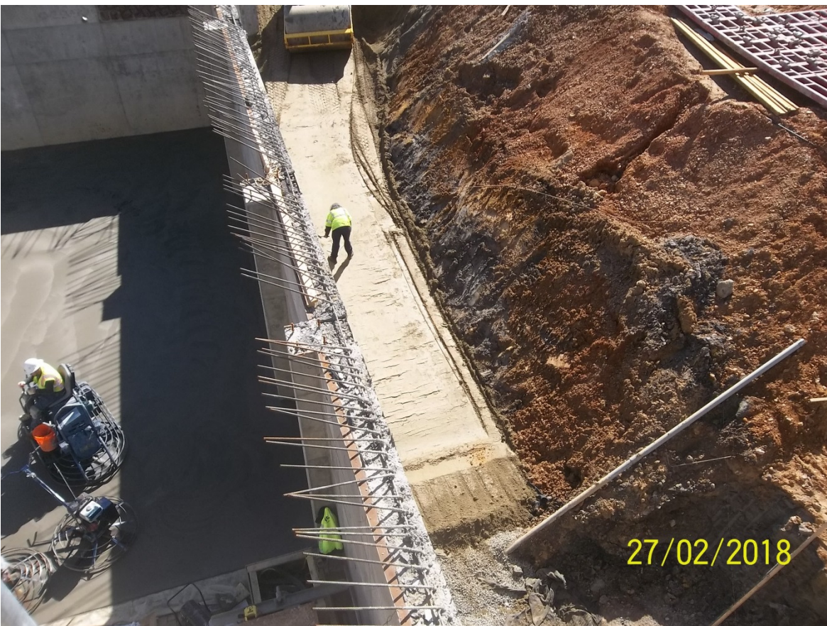
Backfill @B2 level
