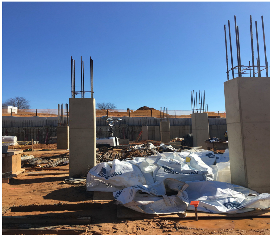
POURED GARAGE COLUMNS
